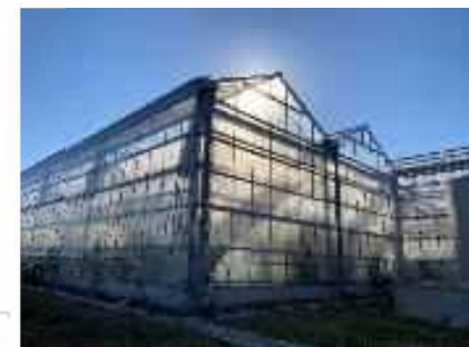
環境制御型ハウス
