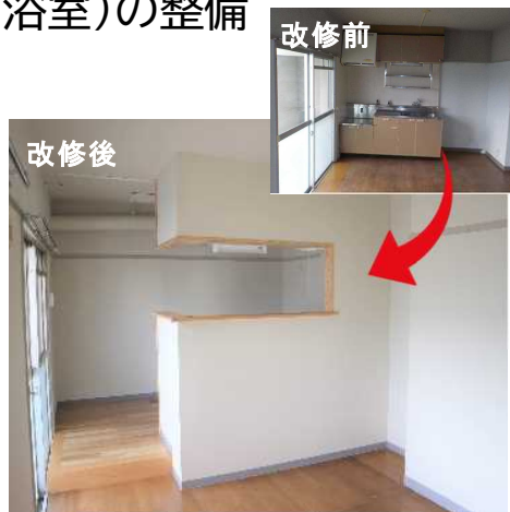
県営住宅の改修事例 (対面キッチン)
