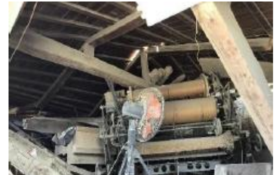
いぐさ製織作業場(施設崩壊)
