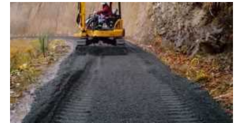
鉄鋼スラグを利用した林道整備
