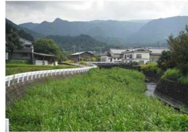
上流からの土砂が河道に堆積し、流下能力が低下
