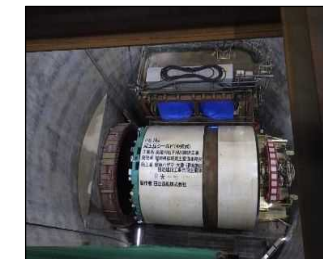
発達立坑内のシールドの組立状況 (H30.8)
