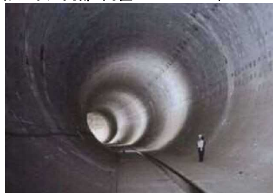
神田川・環状七号線地下調節池
