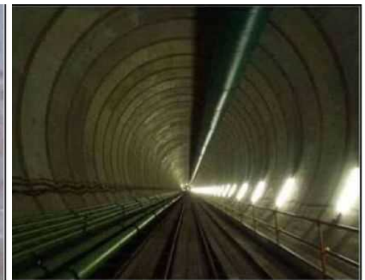
白子川地下調節池
