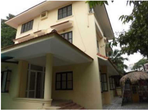
【A棟現況：旧ハイチ大使館】
